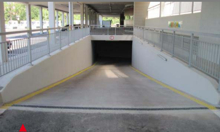
Външно отводняване в зоната на рампите – ACO DRAIN® XtraDrain®
