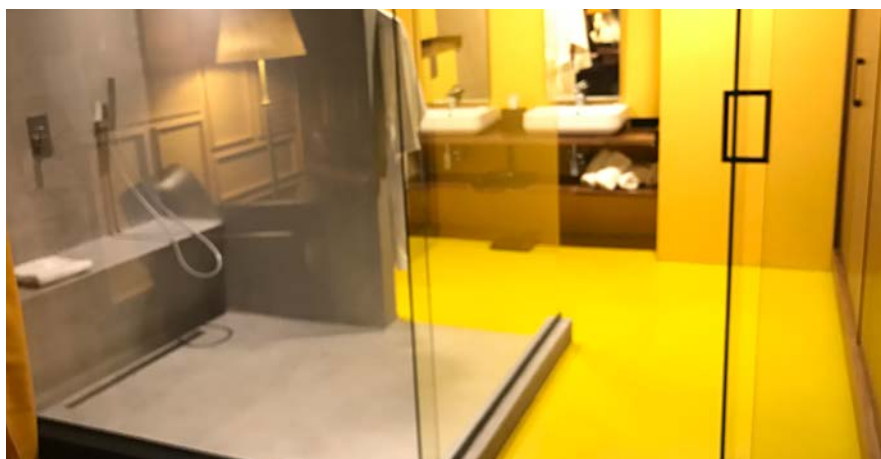
ACO ShowerDrain C душ канал с хоризонтални фланци и решетки Square и Tile за вграждане на настилка.
