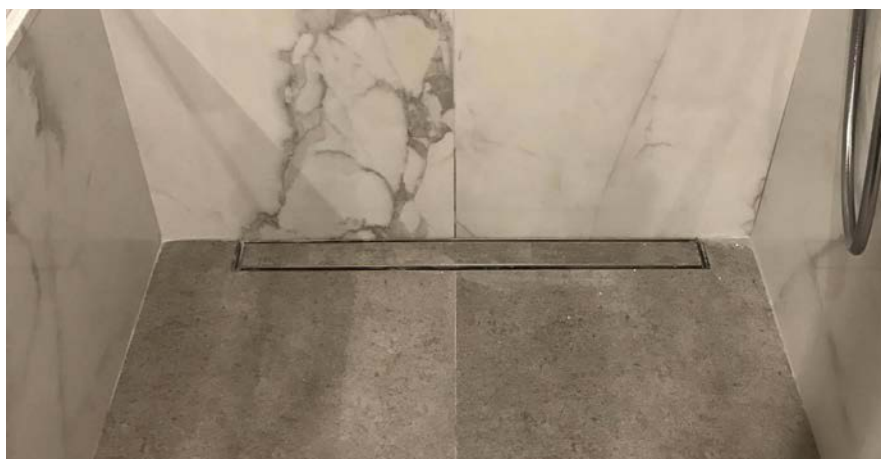
ACO ShowerDrain C душ канал с вертикален фланец и решетка Tile за вграждане на настилка.
