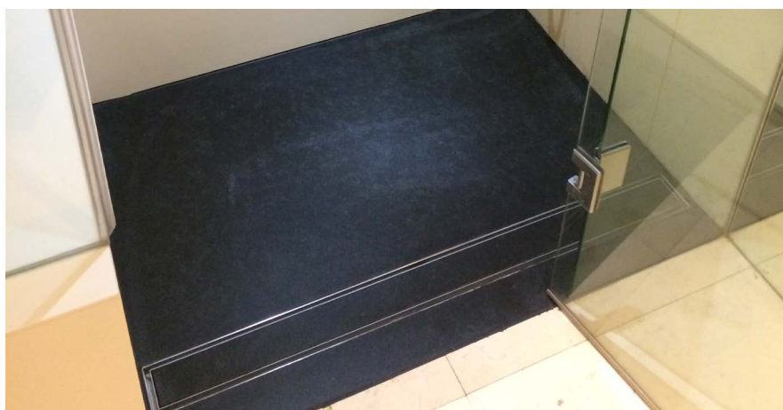
ACO ShowerDrain C душ канал с хоризонтален фланец и решетка Tile за вграждане на настилка.
