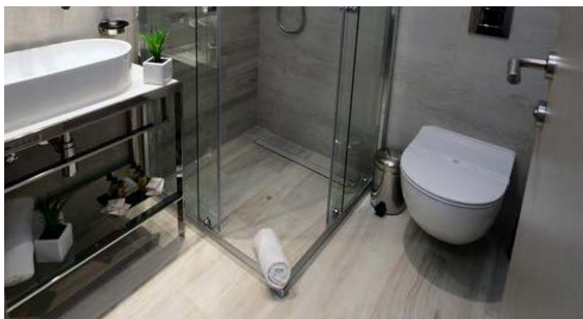
ACO ShowerDrain C душ канал с хоризонтални фланци и решетка Tile за вграждане на настилка.
