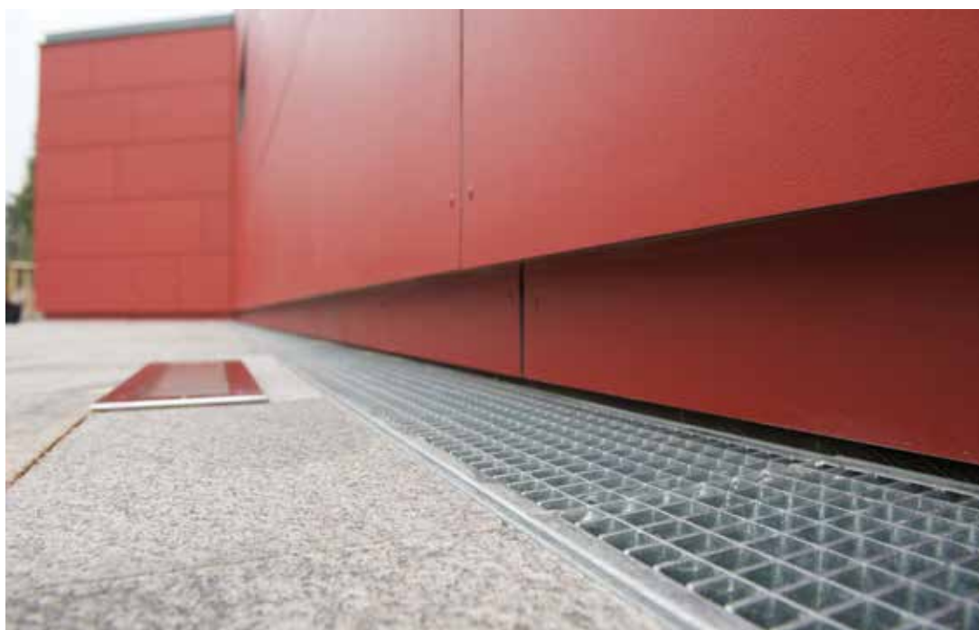
Решетка с кръгли отвори Поцинкована, неръждаема стомана
