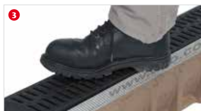
3 Натиснете решетката, докато чуете безболтовото заключване
