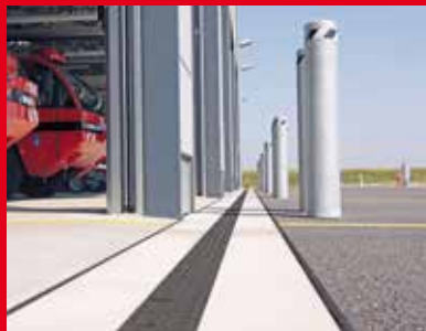
Усилена отводнителна система
