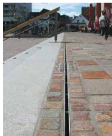
ляво: слотов улей в радиус горе: ACO SlotDrain с отводнителен улей ACO MultiDrain V 100 S
