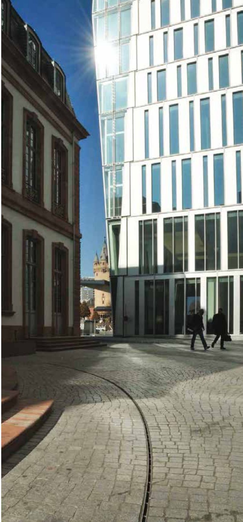
ляво: слотов улей в радиус горе: ACO SlotDrain с отводнителен улей ACO MultiDrain V 100 S
