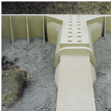
Монтиране на входната и повърхностната част на прохода
