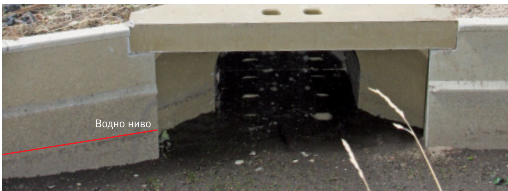
Плочи Klimasohlplatten с дренажна функция след проливен дъжд
