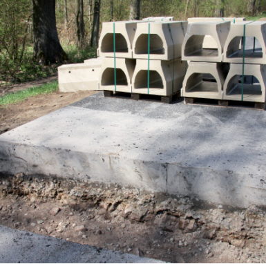
Подготовка на изкопа
