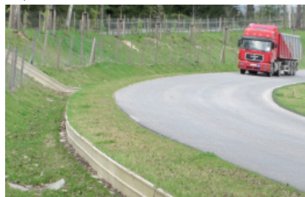
Изграждане на банкет
