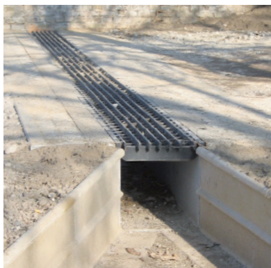
Монтаж в паваж
