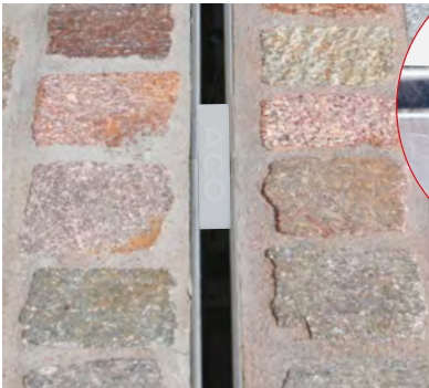
Свързване на слотови решетки със слот конектор
