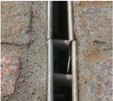
Свързване на слотови решетки без слот конектор
