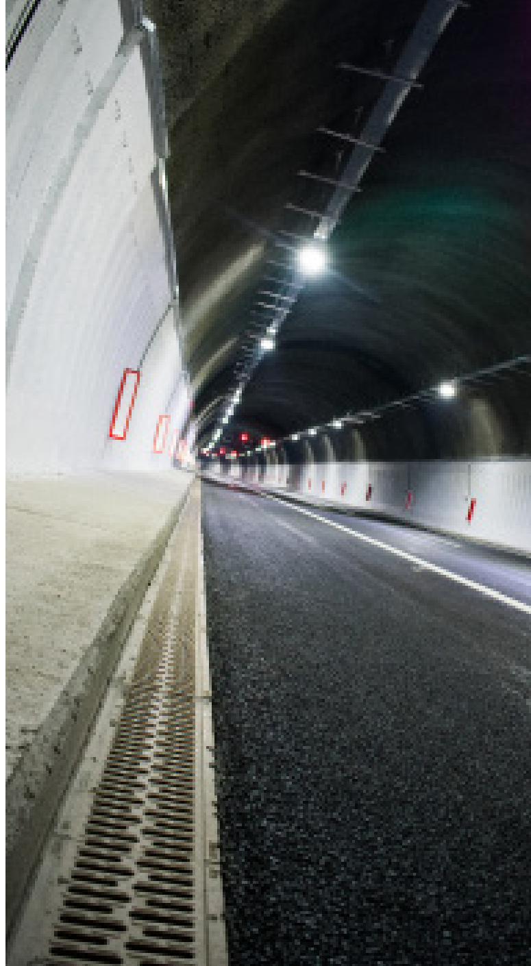
ACO Monoblock - надлъжно линейно отводняване с монолитни отводнителни улеи за тежко натоварване
