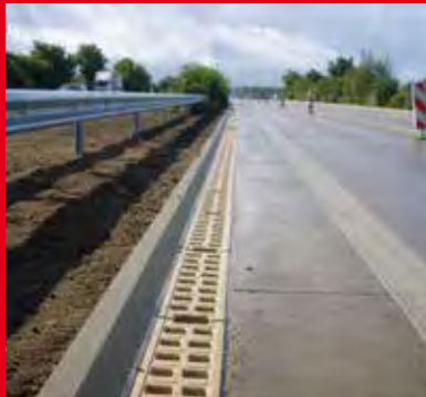
Надлъжно отводняване на магистрала А1 в Германия с ACO Monoblock
