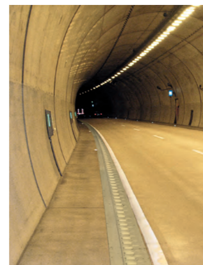
ACO DRAIN® Monoblock T 275 V в тунел
