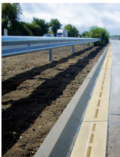
ACO DRAIN® Monoblock SD 200 V надлъжно отводняване на магистрала
