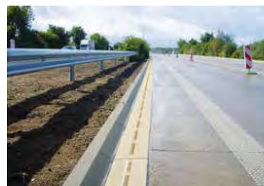
ACO Monoblock SD 200 V надлъжно отводняване на магистрала
