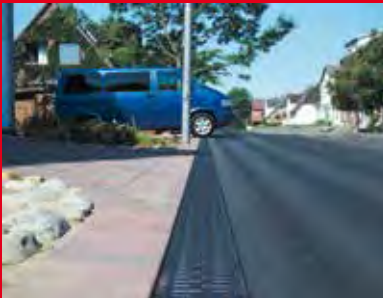
Монолитна отводнителна система
