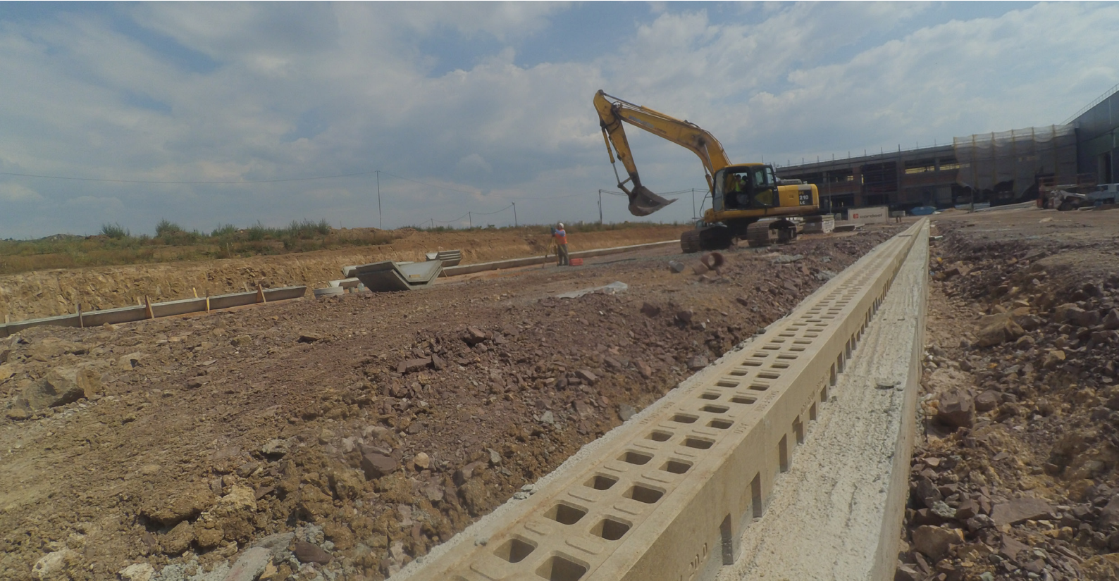
Монтаж на монолитни отводнителни улеи ACO Monoblock RD
