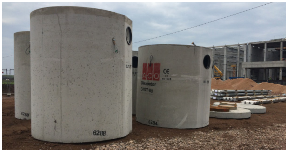
Монтаж на ACO Oleopator C коалесцентни сепаратори за нефтопродукти за големи дебити
