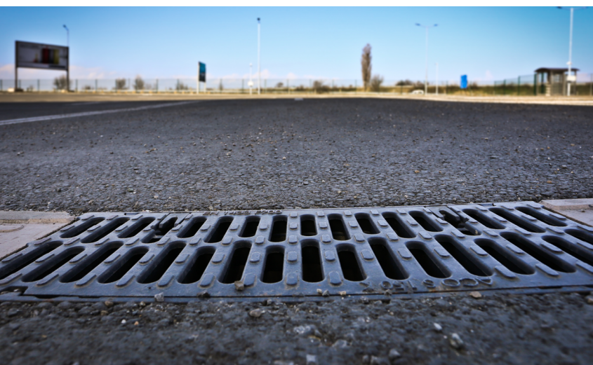
Ревизионна шахта на отводнителен улей ACO Monoblock
