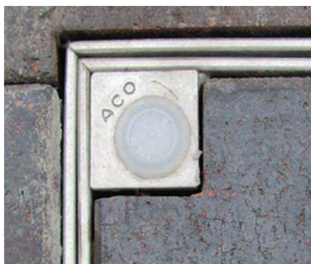
Защита от вандализъм и неотризиран достъп до шахтата посредством заключване
