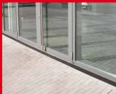
Олекотена отводнителна система
