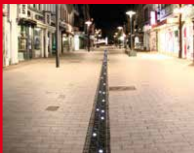
Отводнителна система с интегрирано осветление
