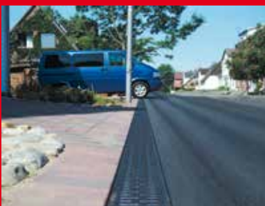
Монолитна отводнителна система
