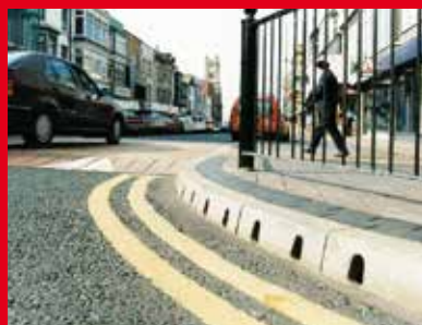
Бордюри с интегрирана отводнителна система
