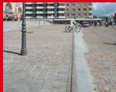
Дискретна слотова отводнителна система
