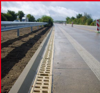
Надлъжно отводняване на магистрала A1 в Германия с ACO Monoblock
