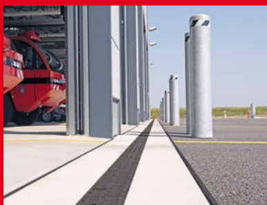
Усилена отводнителна система
