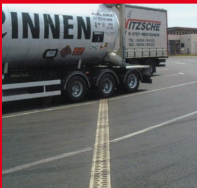
Напречно отводняване с ACO Monoblock
