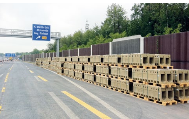
Инсталация на ACO Monoblock RD на магистрала А3, Германия
